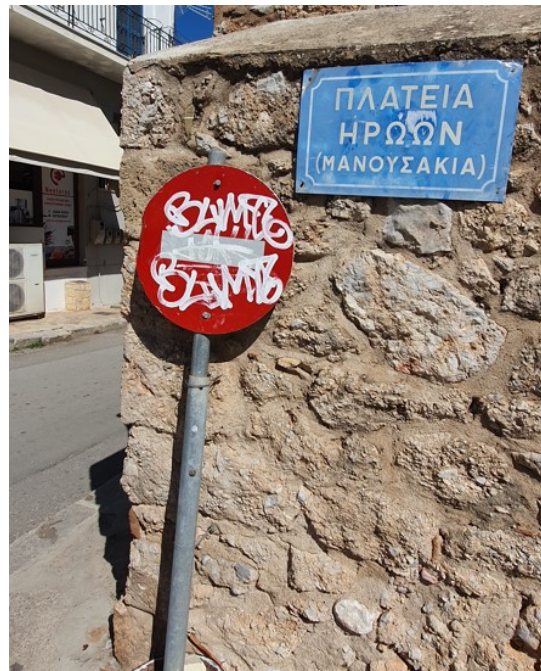
Φθαρμένη κατακόρυφη σήμανση P-7 στην Πλατεία «Μανουσάκια»
