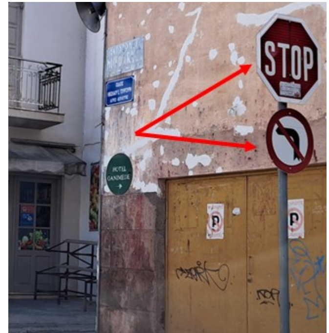
Λανθασμένη τοποθέτηση σήμανσης P-2 «STOP» πάνω από P-27 στην οδό Ν. Γουργουρή
